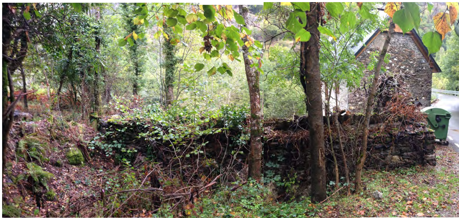
VISTA BORDA FAÇANA SUD-OEST
