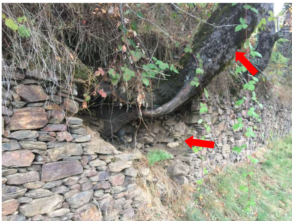
Intervenció 11: Tallar arbre, Preparar base per a mur i refer mur caigut amb recuperació de pedres del propi mur, 2x2 m 2 .
