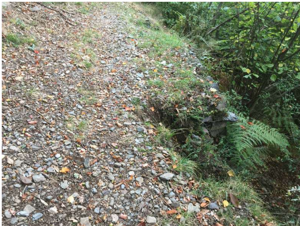
Intervenció 14: Preparar base per a mur i refer mur caigut amb recuperació de pedres del propi mur, fins a l'altura del camí i terraplenat. 2x1 m 2 .
