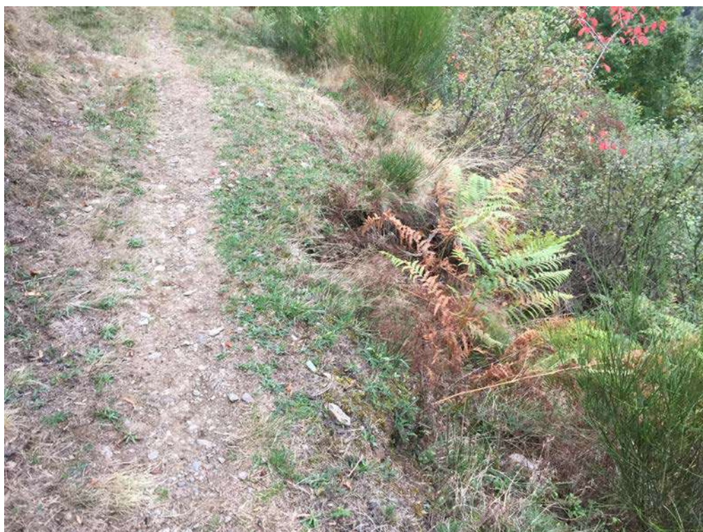
Intervenció 10: Preparar base per a mur i refer mur caigut amb recuperació de pedres del propi mur, fins a l'altura del camí i terraplenat. 2x1 m 2 .
