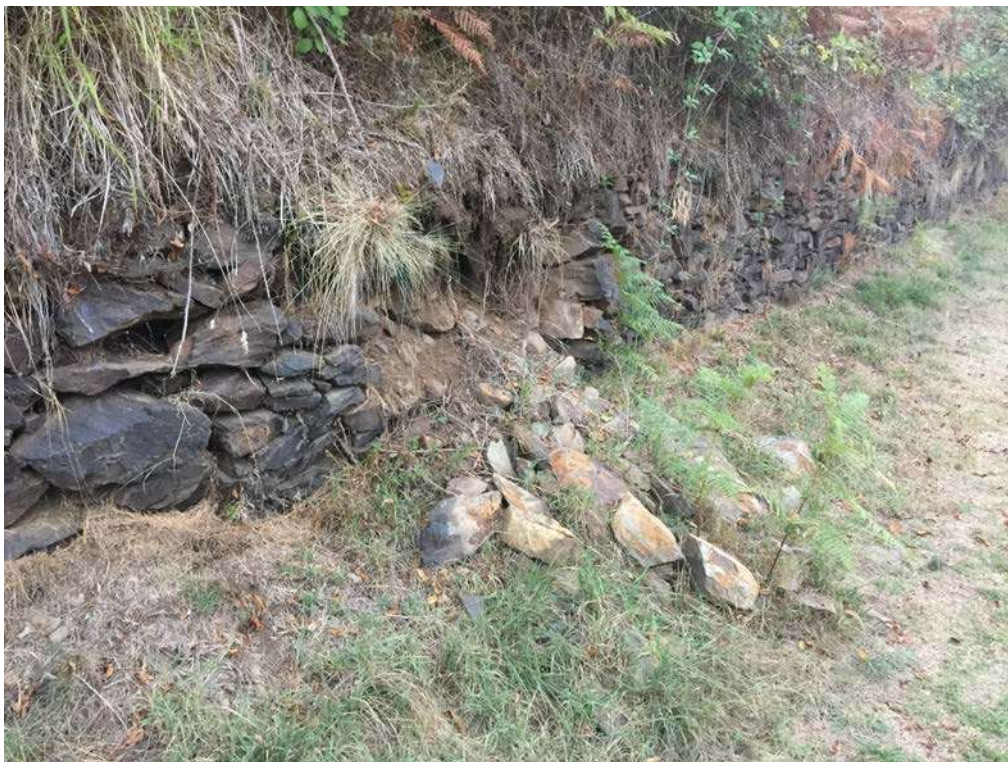
Intervenció 5: refer mur caigut amb recuperació de pedres del propi mur. 3x1 m 2 .
