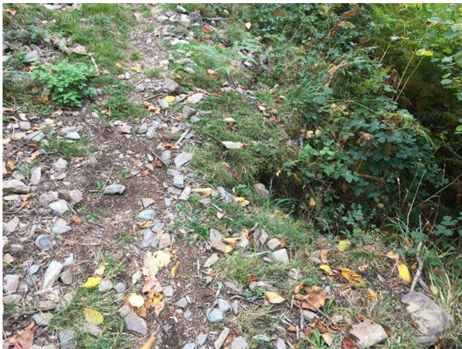
Intervenció 16: Preparar base per a mur i refer mur caigut amb recuperació de pedres del propi mur, fins a l'altura del camí i terraplenat. 1x1 m 2 .
