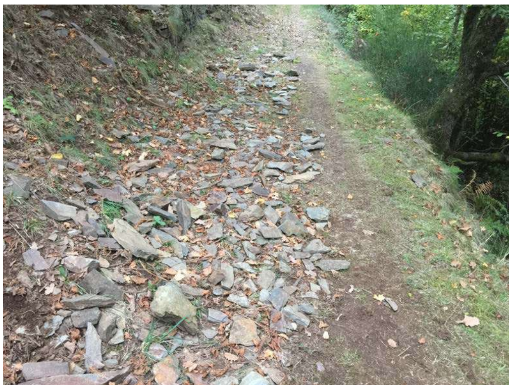
Intervenció 7: Traure acumulació de pedres al camí , una distancia de 20 metres, l'amplada de tot el camí.
