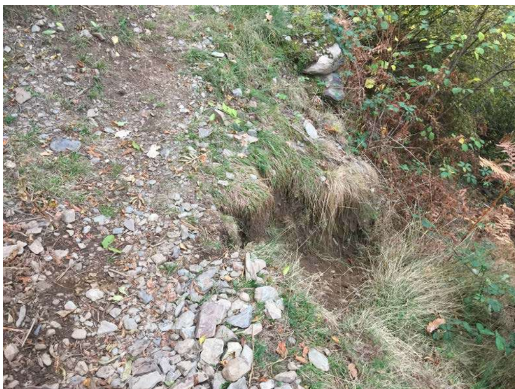
Intervenció 8: Preparar base per a mur i refer mur caigut amb recuperació de pedres del propi mur, fins a l'altura del camí i terraplenat. 1x2 m 2 .
