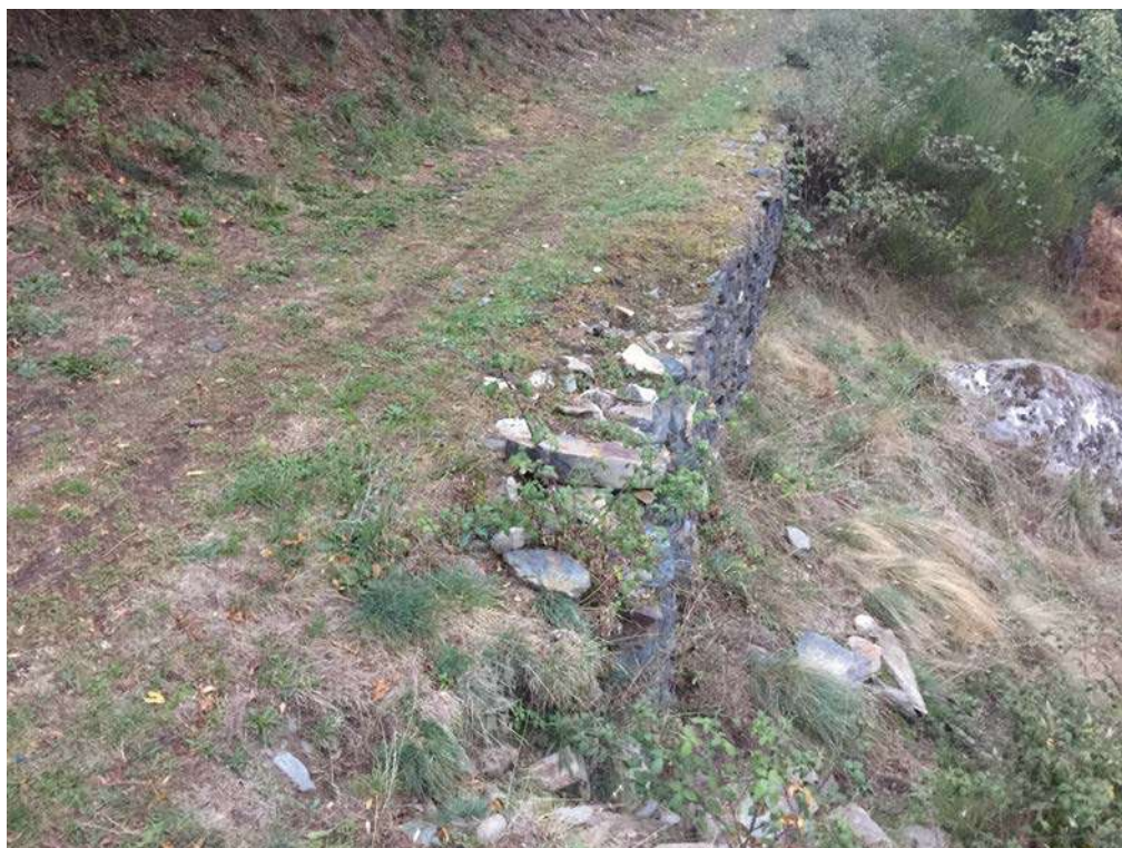
Intervenció 2: Reparar part alta de mur, 1 m 2 .
